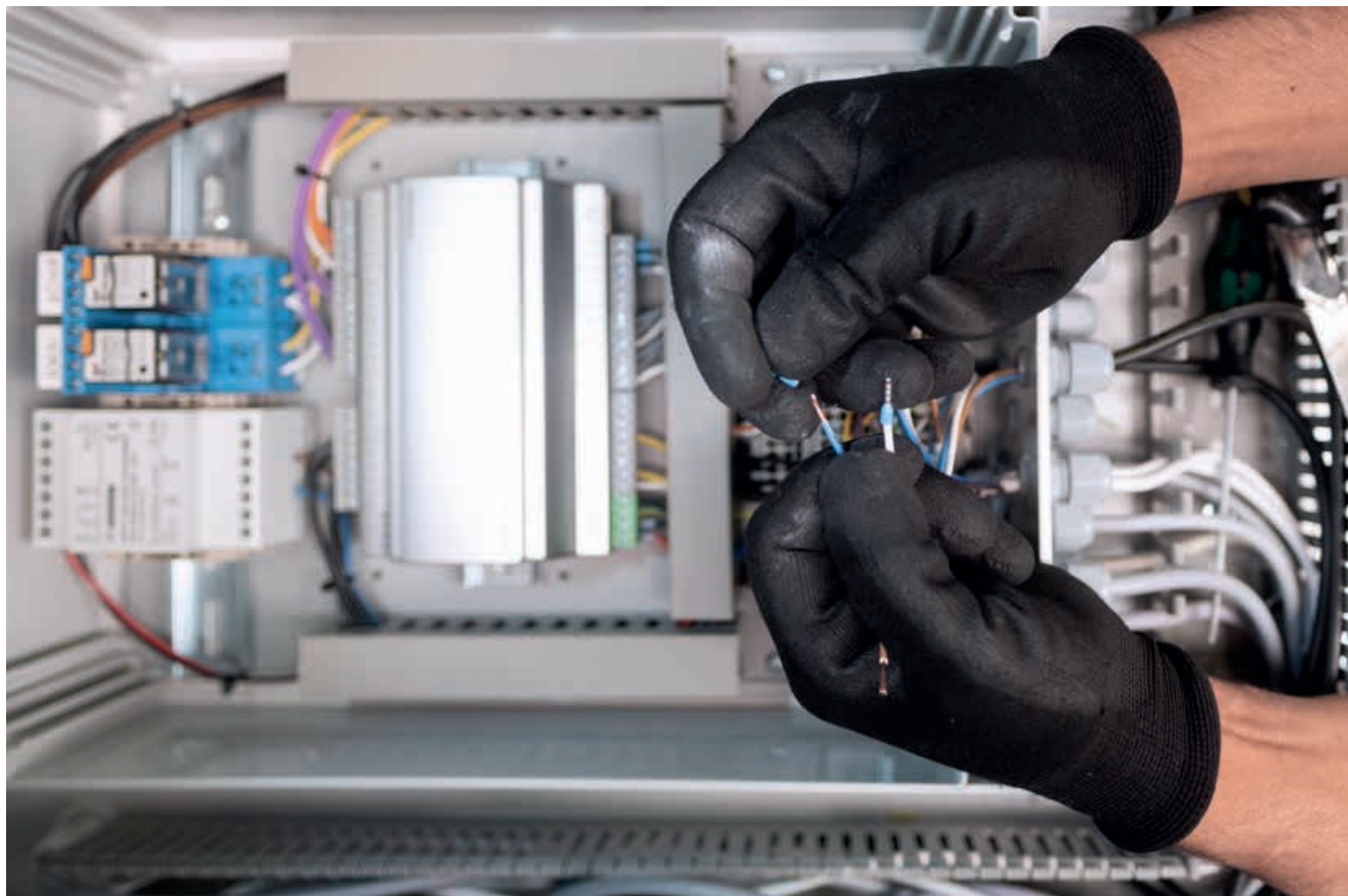
Klemmenstrook met aangesloten Regin-regelaar
